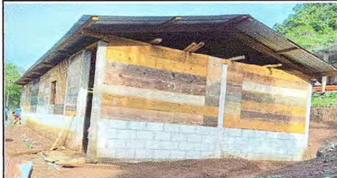
Foto 4: Se observan el levantamiento de 4 hiladas de block, columnas de concreto y el cambio de laminas, incluyendo reglas, tijeras y vigas de madera.
