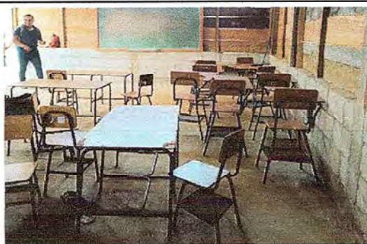
Foto 3: Se observan el piso de concreto en el aula del modulo II.
