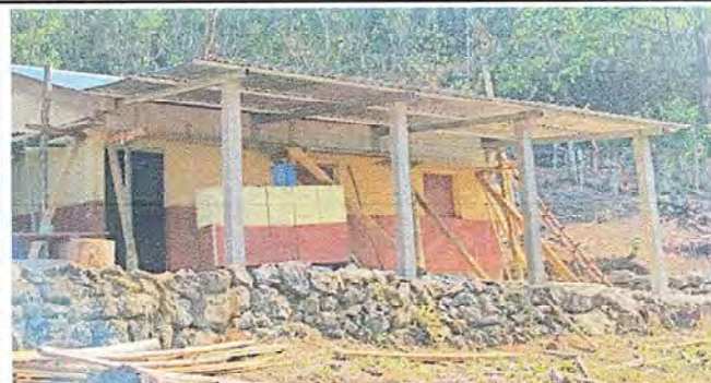
Foto 2: Se cambian las columnas del patio de la Escuela y laminas.
