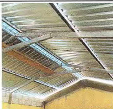
Foto1: Se observan ya instaladas estructura de techo, esto incluye: Laminas troqueladas, Costaneras, Tubos, y dos hiladas de block
